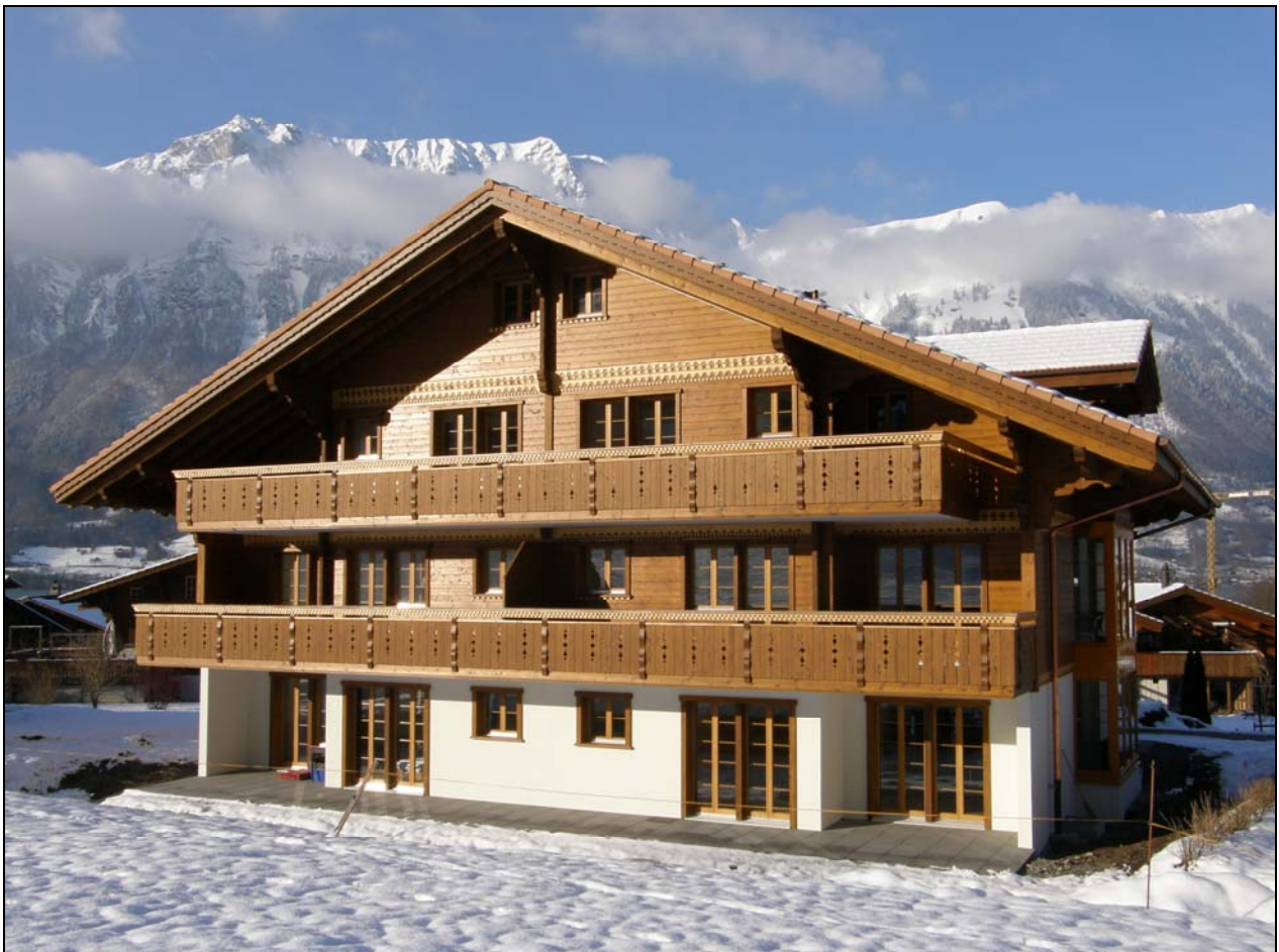
Referenzobjekt Chalet Faulhorn, Iseltwald
